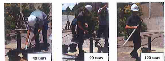
รูปที่ 4.14 การตรวจวัดระดับน้ำและเก็บตัวอย่างน้ำใต้ดินบ่อน้ำ ST02 ระดับความลึก 40, 90 และ 120 เมตร
